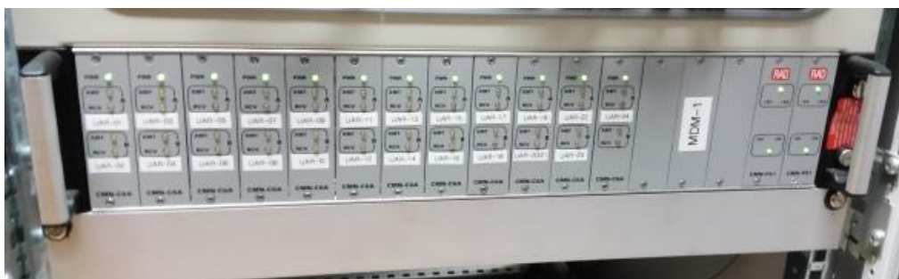
Figura 12 – Rack com os modems RS232 da CDA.
