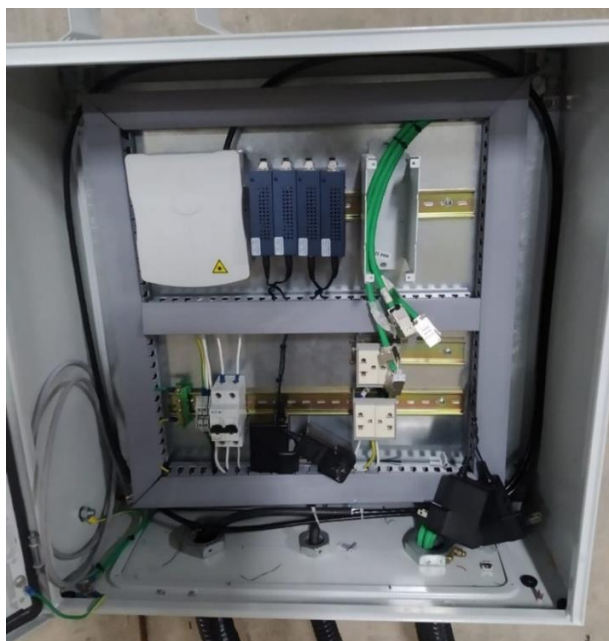
Figura 4 – Detalhe do CFAP - Caixa de Fixação de Access Point
